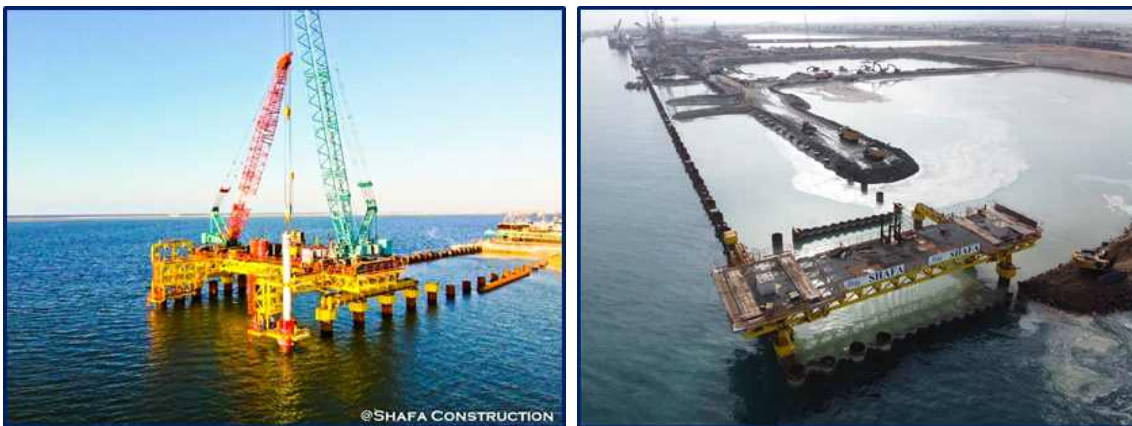
그림 2. Cantitravel System 말뚝 향타 및 배후지 매립 전경
